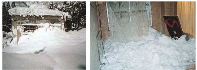
◆大勘場地区 南砺市 表層雪崩による被害/平成8年(1996年2月)
