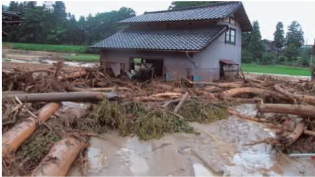
◆流木による被災(南砺市才川七地内)
