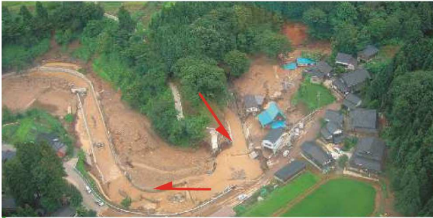
◆小矢部川水系太谷川(南砺市小二又地内) 土石流により太谷川が閉塞し、人家、公共施設が被災。
