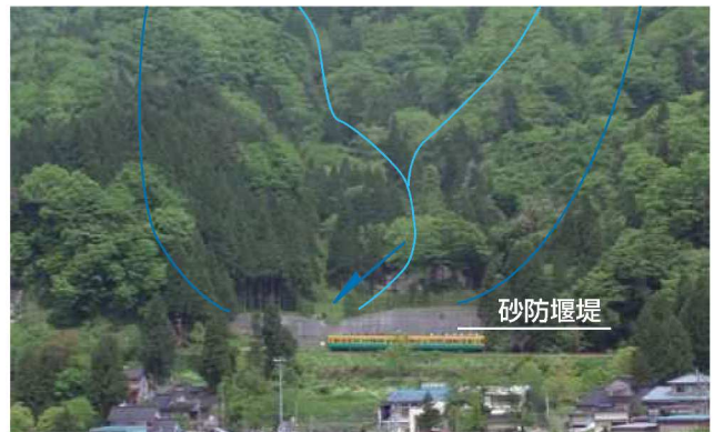
◆常願寺川水系千垣中の谷(立山町千垣地内) 砂防堰堤が下流の人家、県道、鉄道を土石流から守っています。
