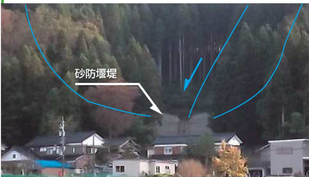
◆片貝川水系長引野東谷(魚津市長引野地内) 砂防堰堤が下流域の人家、県道、耕地等を土石流から守っています。
