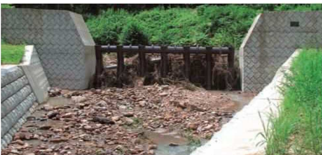
◆小矢部川水系セド谷堰堤(南砺市才川七地内)
