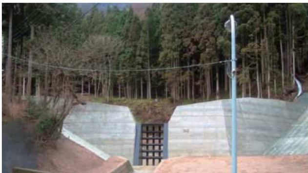
◆透過型砂防堰堤 庄川水系前川谷砂防堰堤(南砺市杉尾地内)
