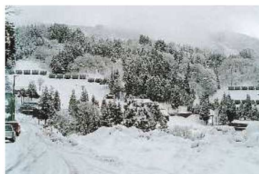
◆北豆谷地区 南砺市 雪崩予防柵(予防工)
