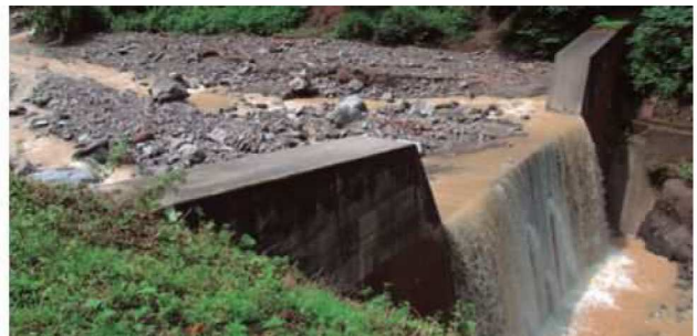
◆小矢部川水系蛇谷川砂防堰堤(南砺市吉見地内)
