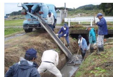
多面的機能支払制度を活用した 水路の補修作業(氷見市中尾)
