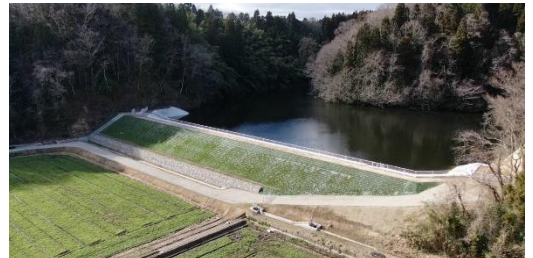
ため池の老朽化・耐震化対策整備 (水見市島山池)
