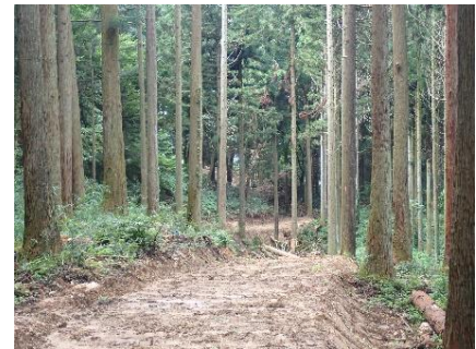
森林整備に活用される森林作業道 (射水市串田)
