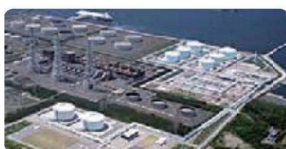
新潟LNG基地
