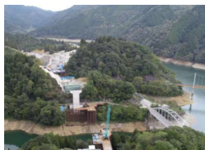
九頭竜・油坂間の工事状況
