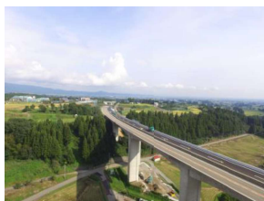
五箇山IC～城端SIC 四車線化完成区間
