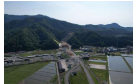
▼浜坂道路Ⅱ期 整備状況
