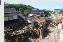
流木等による住家の損傷（石川県）
