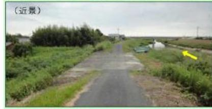
出典:九州地方整備局河川部ウェブサイト ※「野越し」…佐賀県の城原川に存在する、堤防の一部を低くすることで洪水の水を川の外に溢れさせる施設の呼称
