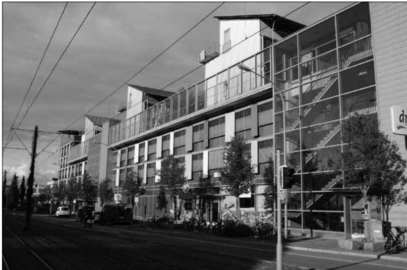
ソーラー住宅地区のメゾネット型のテラス 高い省エネ性能と大きな太陽光発電により、エネルギー収支が黒字（平均36kWh/m 2 年 生産超過） となる住宅
