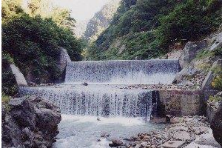
【資料4】 自然災害を減らすための砂防ダム
