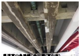
県道富山魚津線 今川橋(富山市) 現橋の損傷状況
