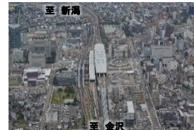
富山駅付近連続立体交差事業
