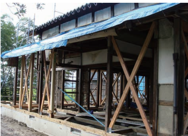
住宅の耐震改修工事
