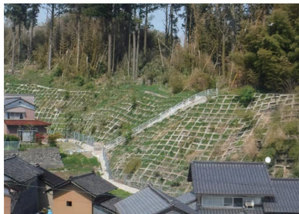
急傾斜地崩壊防止施設の整備(水見市朝日丘地区)
