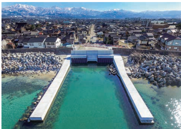
河川(放水路)の整備(沖田川放水路)
