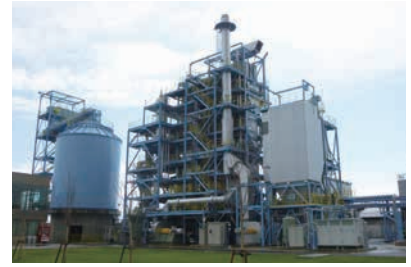
未利用間伐材を活用した木質バイオマス発電施設 射水市、出力5,750kW (株)グリーンエネルギー北陸
