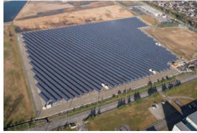
富山新港太陽光発電所 射水市、出力4,500kW (県企業局)
