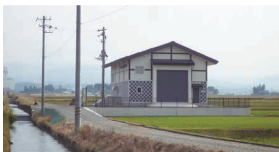
農業用水を活用した仁右工門用水発電所
