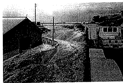
宮崎漁港(朝日町)の高波による越波(2008<H20>年2月)
