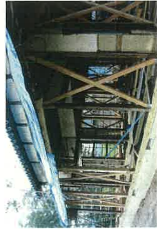
住宅の耐震改修工事
