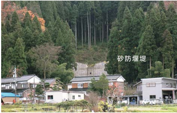
砂防堰堤の整備 (魚津市長引野東谷)
