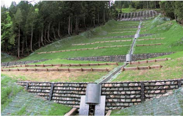
治山施設の整備(南砺市下梨地区)
