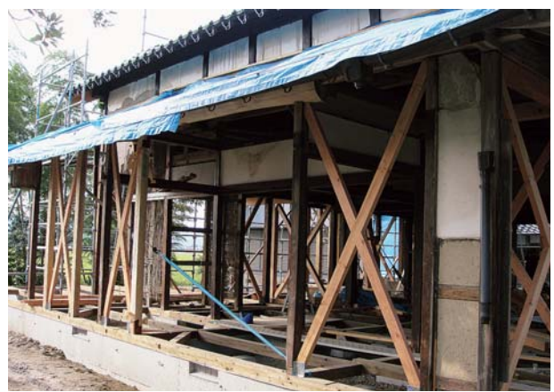
住宅の耐震改修工事
