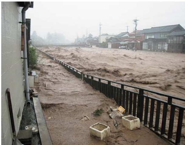
山田川(南砺市)の氾濫(2008(H20)年7月)
