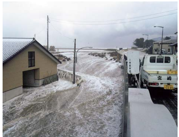
宮崎漁港(朝日町)の高波による越波(2008(H20)年2月)
