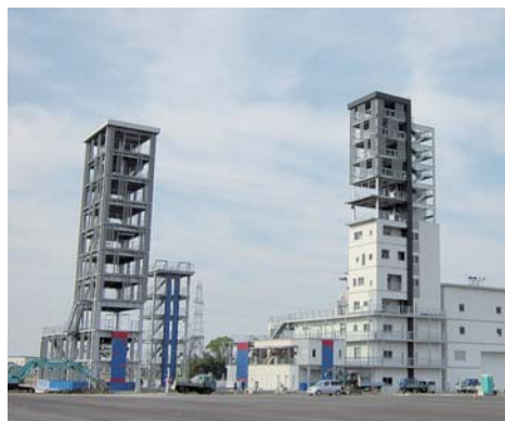
主訓練塔(高さ45m)
