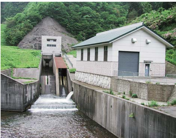
白中発電所（農業用水を利用した小水力：南砺市）
