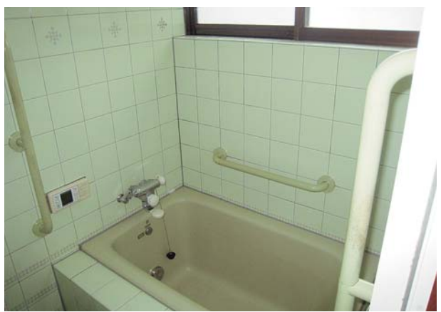
住宅のバリアフリー化(手すりの設置)
