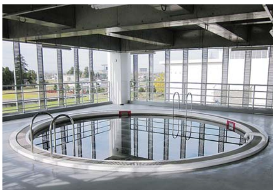
水難救助訓練施設(深さ10m)
