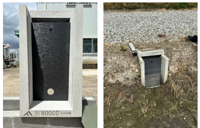
写真1：機能分離型田んぼダム用排水槽（富山県作成）と設置例
