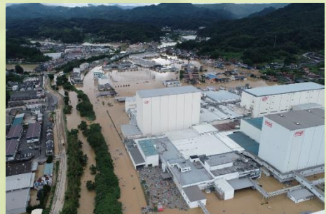
堤防決壊により浸水した工場 (写真：国土交通省中国地方整備局)
