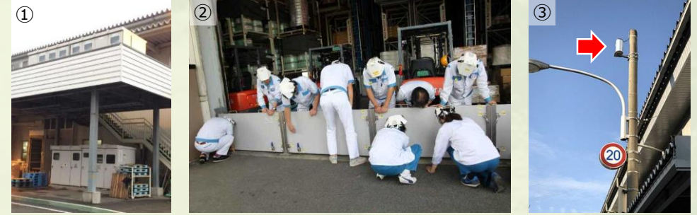
①2階に移設した受電設備 ②防水板設置訓練の様子 ③トヨックスが設置した雨量計 (写真：①②内閣官房「国土強靱化 民間の取組事例集 (平成31年4月)」 ③気候変動適応情報プラットフォーム (A-PLAT) の写真を当センターで一部改変)
