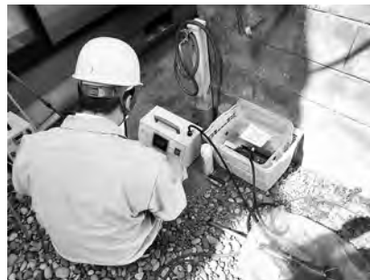
粉じん漏えい防止の確認
