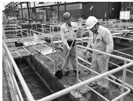
排水処理施設の確認
