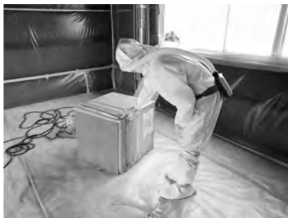
作業場内の養生の確認
