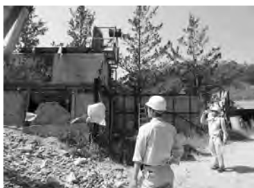
中間処理施設の調査
