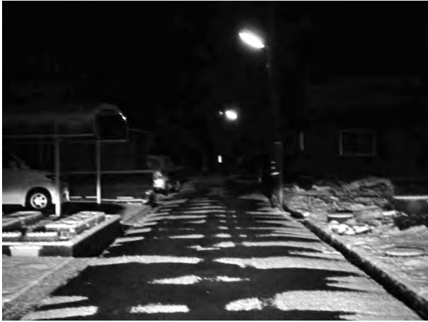
図 5.5 No. 5 区間の道路状況
