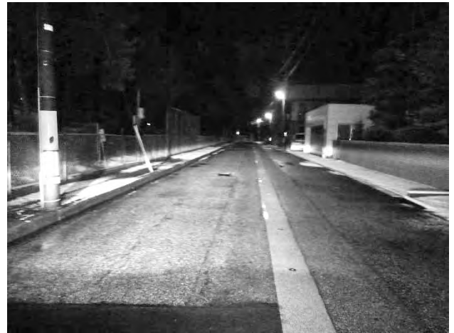
図 5.8 No. 9 区間の道路状況
