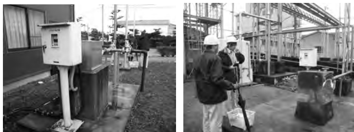
地下水揚水設備の調査
