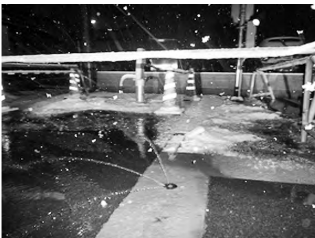
図 5.9 No. 10 区間の道路状況
