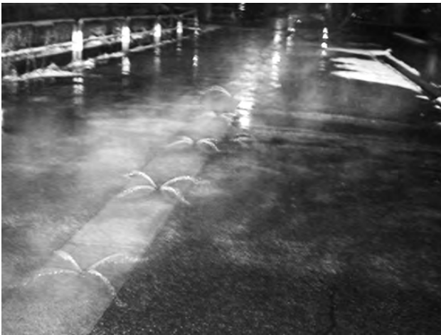
図 5.1 No. 1 区間の道路状況
