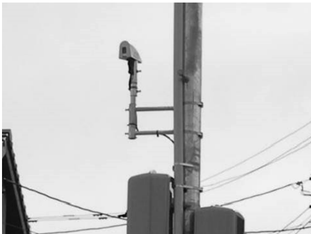
図2 降雪センサー (雪見窓)
