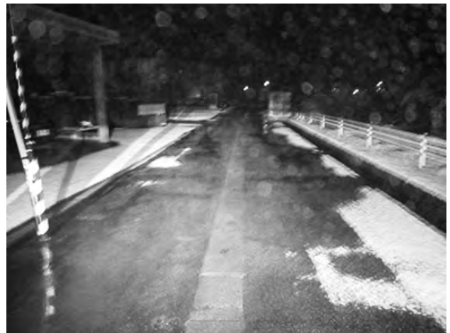
図 5.4 No. 4 区間の道路状況
