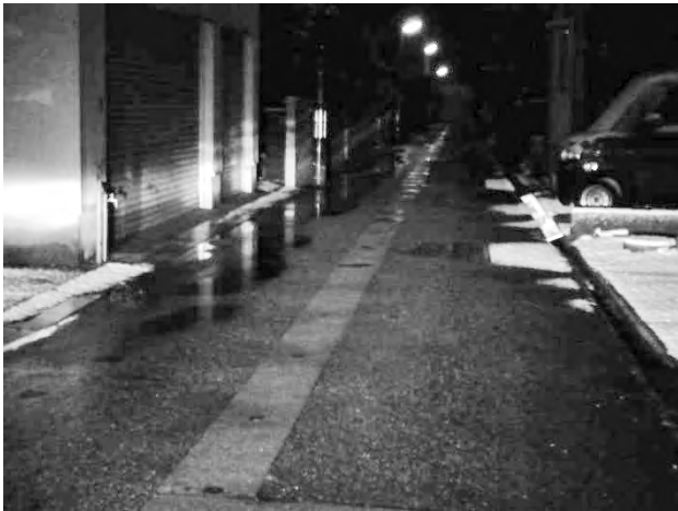
図 5.7 No. 8 区間の道路状況
