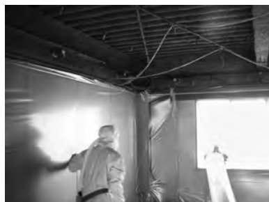
作業場内の養生の確認
