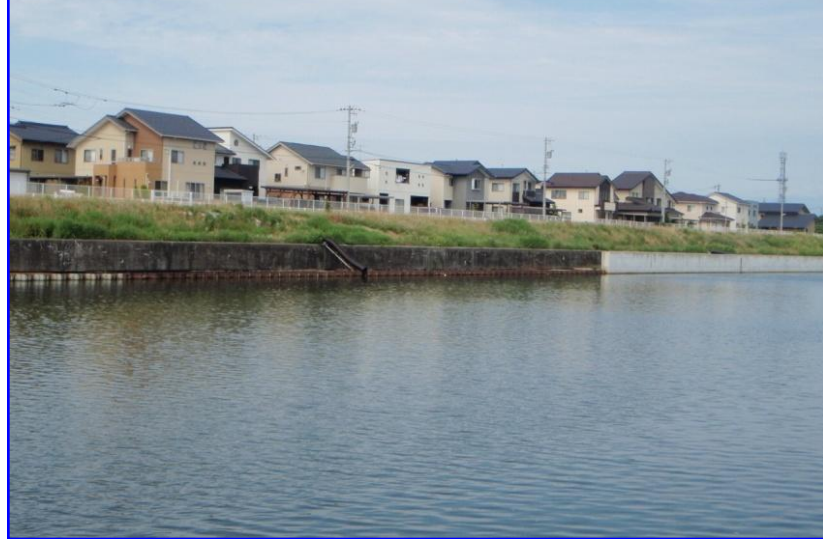
住友運河右岸(蓮町地内) 整備状況
