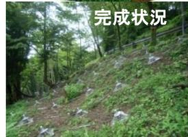
補強材としてロックボルトを地山に削孔挿入し、セメントミルクで固定します。その後、頭部に支圧板を取り付け、ワイヤロープにより各頭部を緊結します。
