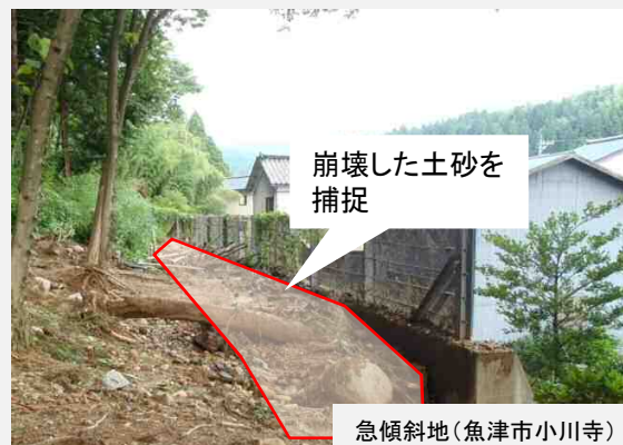
待受け擁壁に堆積した土砂の除去
