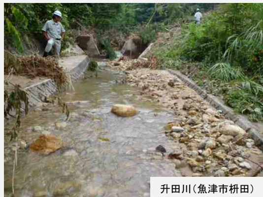
河川内に堆積した土砂の浚渫
