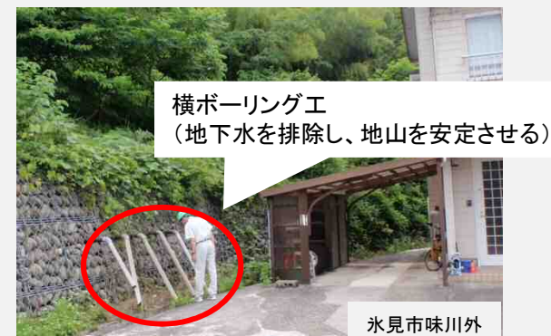
機能低下した横ボーリング工の洗浄
