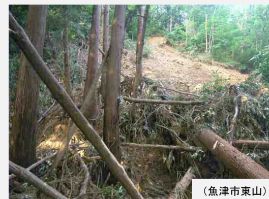
崩壊した山腹斜面の復旧
