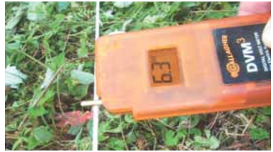
電圧を測定中（専用の電圧計があれば便利）
