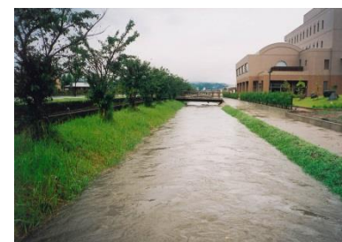
茶ノ木川 小矢部市 驚 島地内
