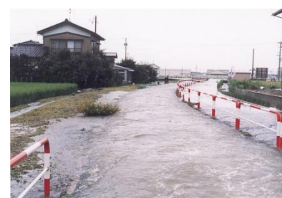
舟戸口用水路 砺波市千保地内
