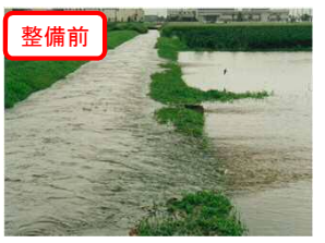
整備前 (一期地区) 狐島用水路
