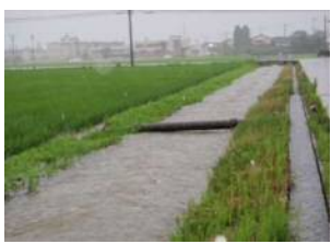
上黒石川排水路 砺波市鷹栖出地内
