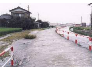
舟戸口用水路 砺波市千保地内
