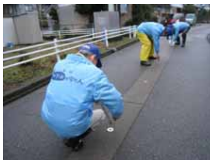
散水ノズルの点検
