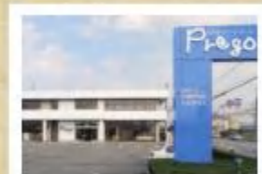
日本海ガス株式会社 ショールーム Prego
