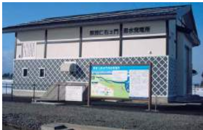
仁右エ門用水発電所 (出典：富山県資料)
