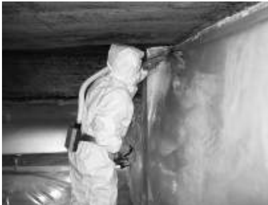
アスベスト除去等作業現場の立入調査
