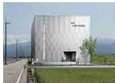
小摺戸発電所（仮称、入善町）
