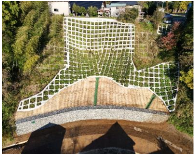
治山施設災害復旧事業 法枠工
