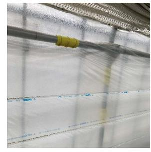
写真 3 空気膜 2 重構造による保温性向上（省エネ）
