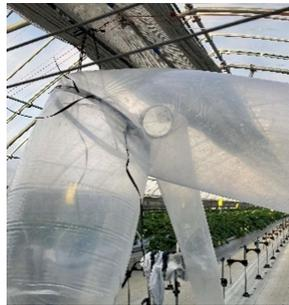
写真 2 送風ダクトによる温度ムラの改善（単収向上）
