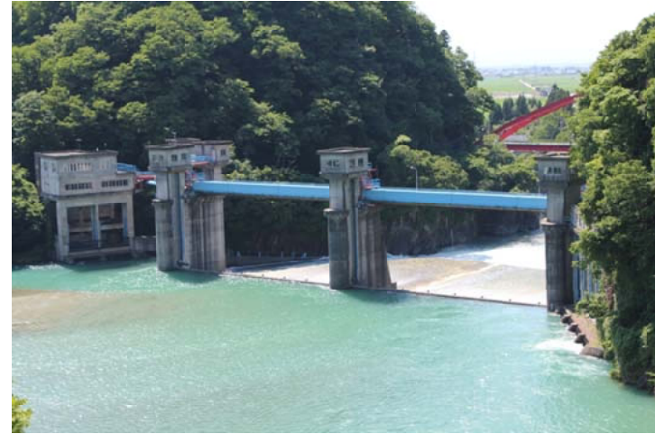
愛本堰堤 右岸上流側より
