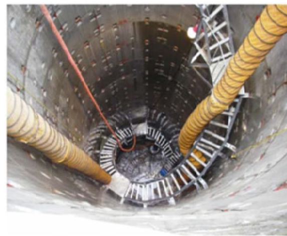
集水井施工状況
