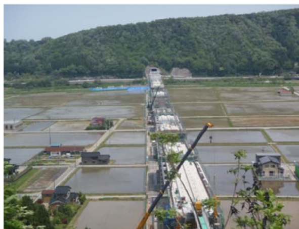
地区を横断する新幹線施設
