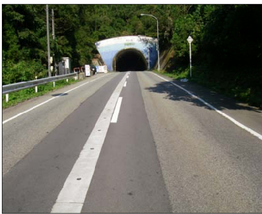
消雪設備の設置 (黒部市 阿古屋野トンネル付近)
