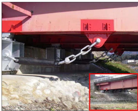
大型の鎖で連結した落橋防止対策工法 (黒部市 布施川橋)
