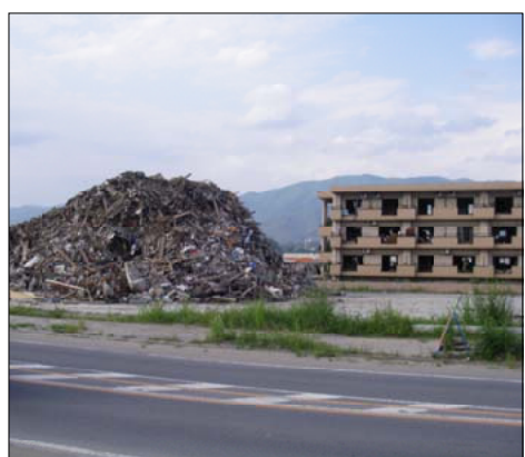
ガレキの処理が進まない状況
