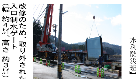
改修のため、取り外された入口制水ゲート(幅約4m、高さ約3m)
