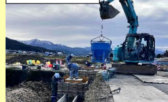
コンクリート打設
