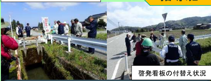
ガードレール隙間の対策状況
