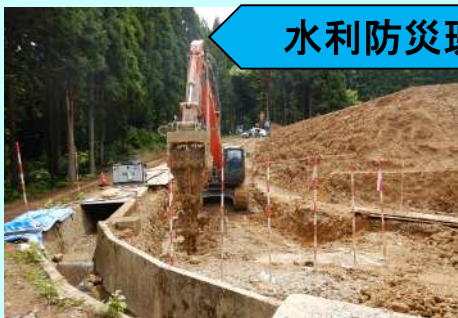
【ため池整備 美濃輪池地区 (朝日町)】
