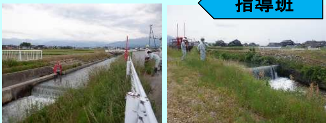
【取水施設の一斉点検】
