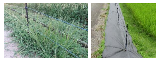
図3 雑草の接触により漏電している電気柵(左)
