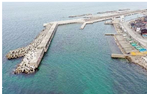
宮崎漁港における防波堤等の整備
