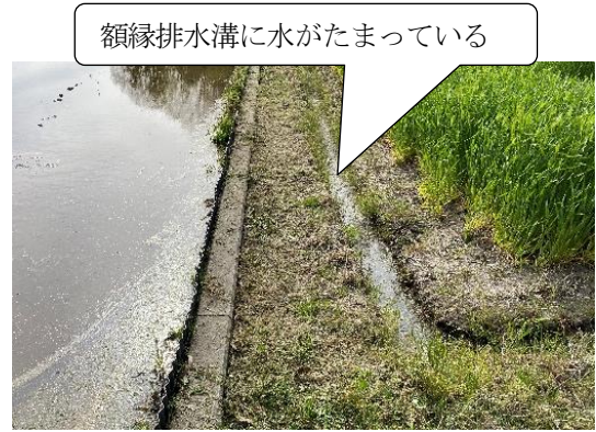
図5 隣接田から漏水しているほ場
