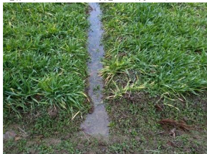
溝が連結されていない
