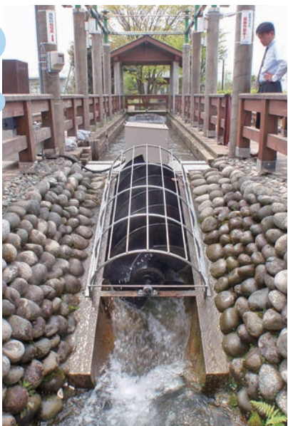
実証実験入善町「水の小径」 最大出力3.6kW (入善町上野)
