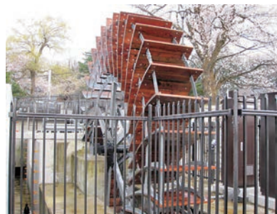
常西公園小水力発電所 最大出力9.9kW (富山市上滝)
