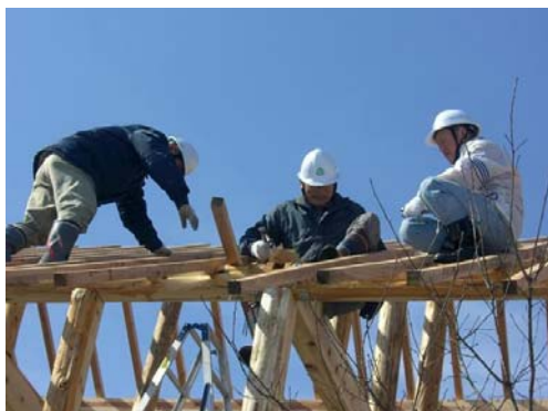
県産材休憩小屋建設状況
