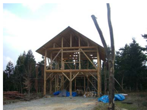
休憩小屋完成
