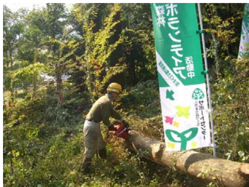
支障木の処理
