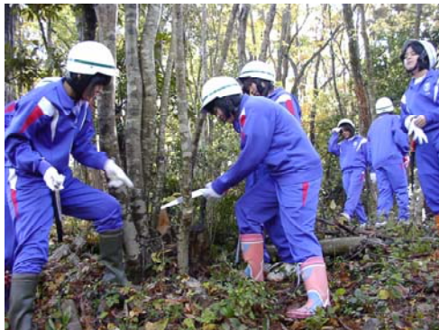
支障木の処理
