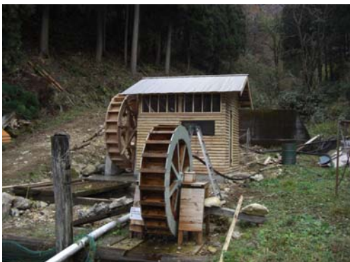
水車・水車小屋（完成）
