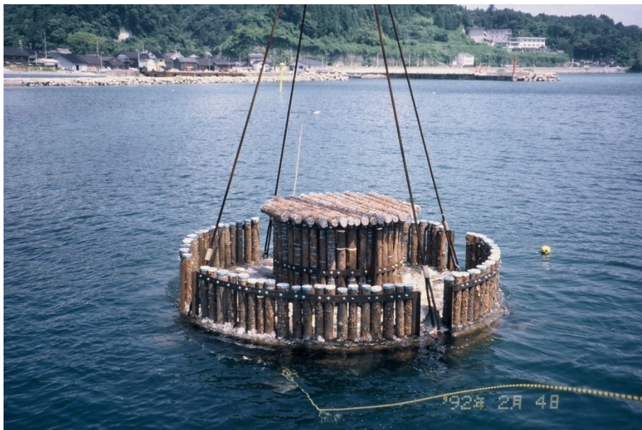
地元の間伐材を活用 した魚礁の設置(氷見市)
