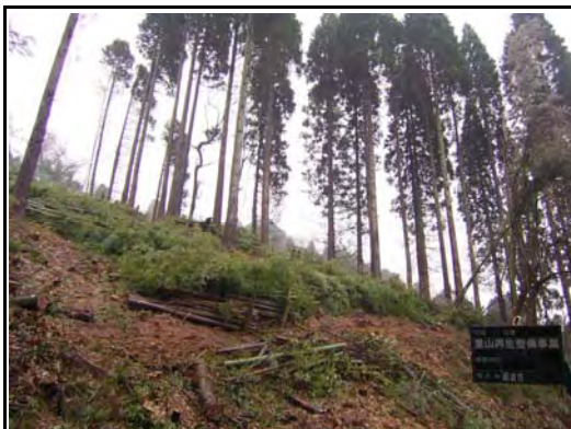
整備後の状況
