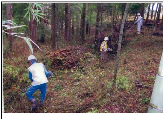
整備後の状況
