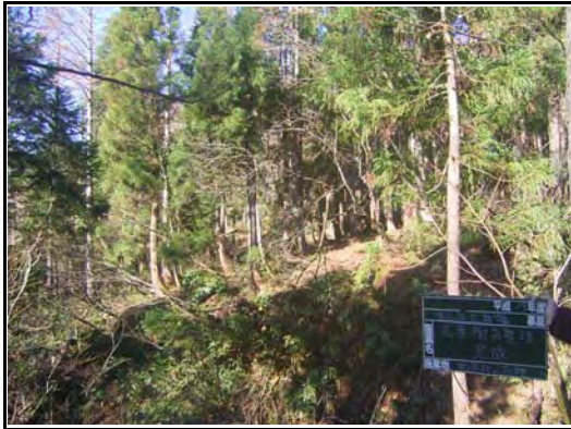
整備後の状況
