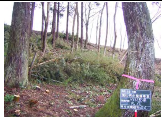
整備後の状況
