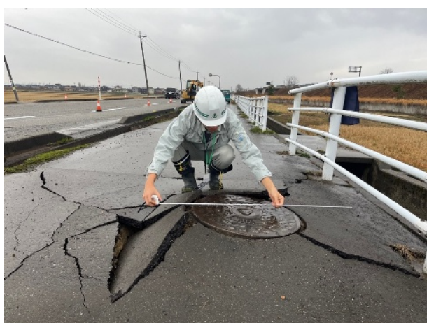
MH 付近の陥没 (高岡福岡幹線 (高岡市国吉地区))
