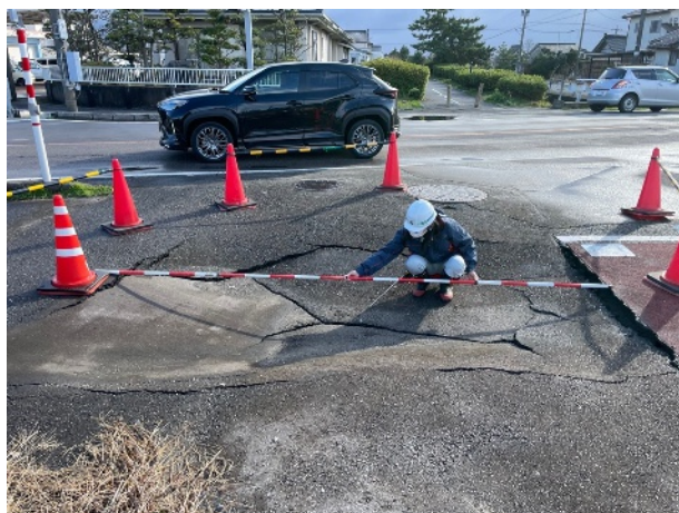
MH 付近の陥没 (高岡福岡幹線 (高岡市国吉地区))
