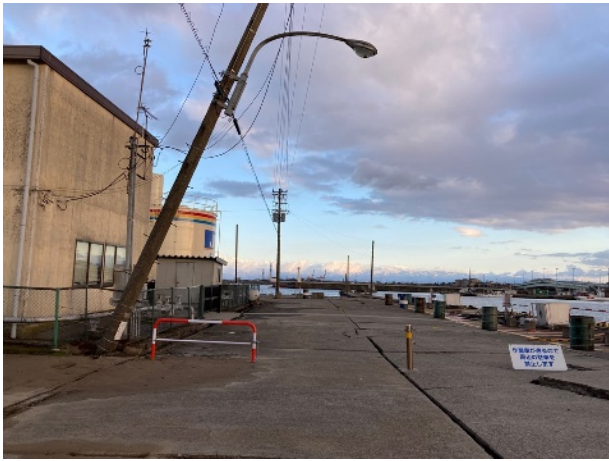
新湊漁港（液状化による施設の損傷）
