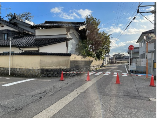
県道井栗谷大門線での家屋倒壊（射水市下条地区）
