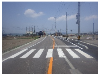
歩道整備完了箇所
