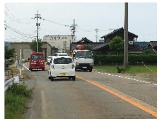
歩道未整備箇所
