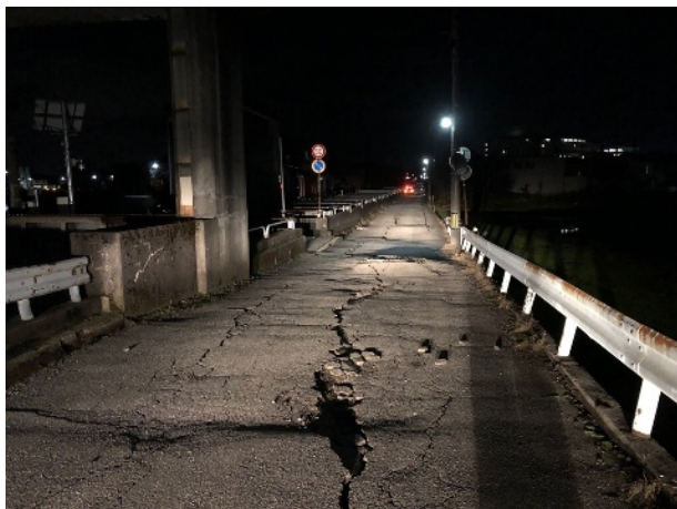
和田川樋門パトロール状況 (高岡市永楽町)
