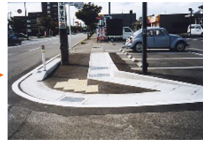
波打ち歩道が平坦になり、段差も解消され、快適な歩行空間ができました。
