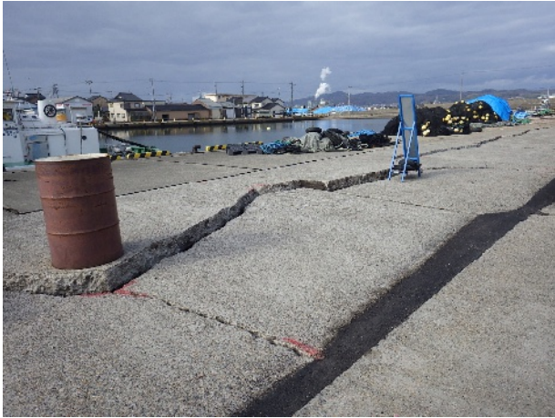
新湊漁港（液状化による施設の損傷）
