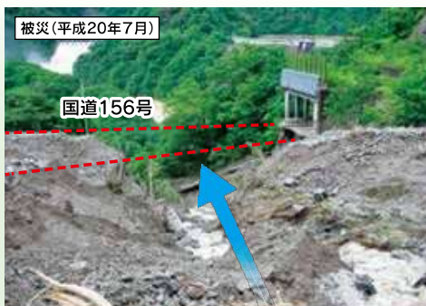
南砺市 祖山出谷砂防堰堤の整備（平成20年～26年）
