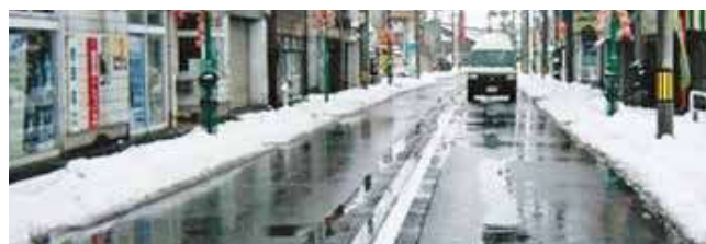
消雪施設の整備
