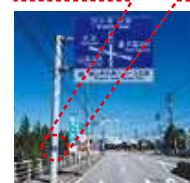
既設道路標識柱への 海拔等の表示
