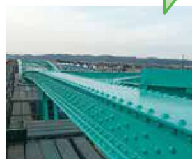
鋼橋の防食機能維持
