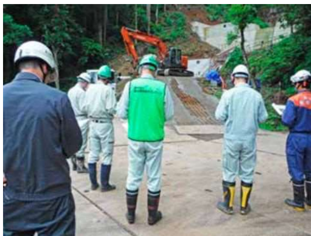
危険箇所の点検
