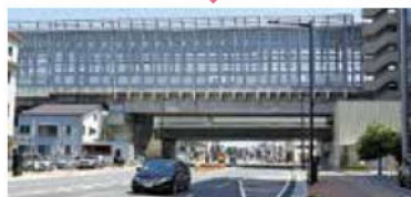
令和6年3月完成（平面4車線化）
