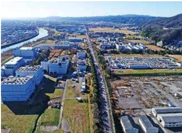
小矢部川流域下水道 二上浄化センター (高岡市二上地内)
