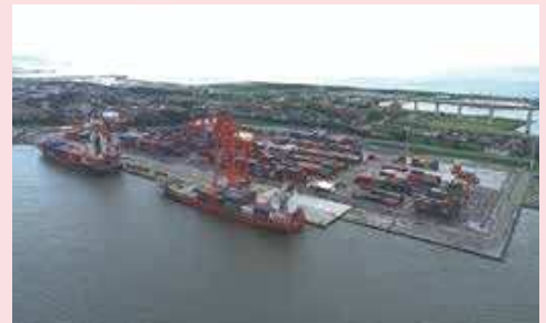
新湊地区国際物流ターミナル (国土交通省北陸地方整備局提供)
