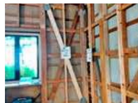
木造住宅の耐震改修工事
