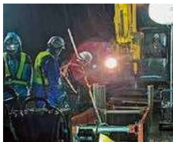
生活インフラを支える夜間工事
