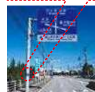
既設道路標識柱への 海拔等の表示
