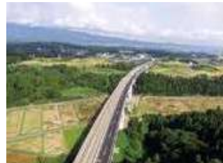
4車線化完成区間 (五箇山IC～城端スマートIC)
