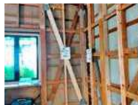
木造住宅の耐震改修工事
