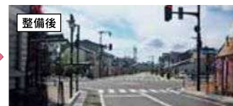
電線共同溝整備による無電柱化【県道高岡氷見線（高岡市木舟町地内）】
