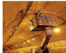
トンネル点検
