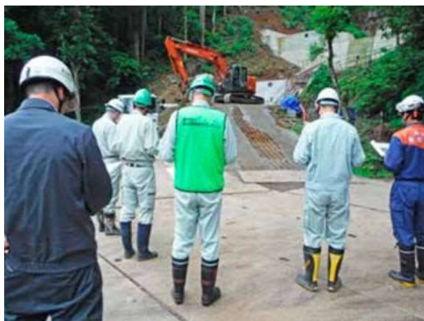
危険箇所の点検
