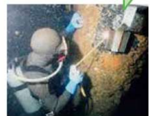
港湾岸壁の防食機能維持
