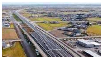
高岡環状線(上伏間江～二塚高架橋)
