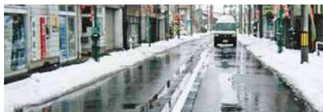
消雪施設の整備
