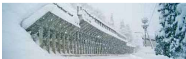
雪崩対策施設
