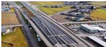
高岡環状線(上伏間江～二塚高架橋)高架化(暫定2車線)供用
