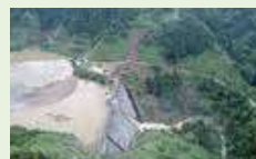
洪水時の城端ダム
