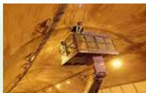
トンネル点検
