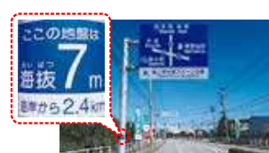
既設道路標識柱への海拔等の表示
