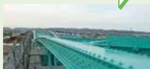
鋼橋の防食機能維持
